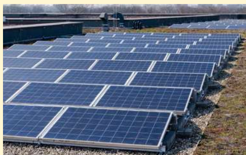
Die räumliche Trennung von Photovoltaikflächen und Dachbegrünung vereinfacht die Pflege und reduziert eine mögliche Verschattung durch den Bewuchs: dm-dialogicum in Karlsruhe.
