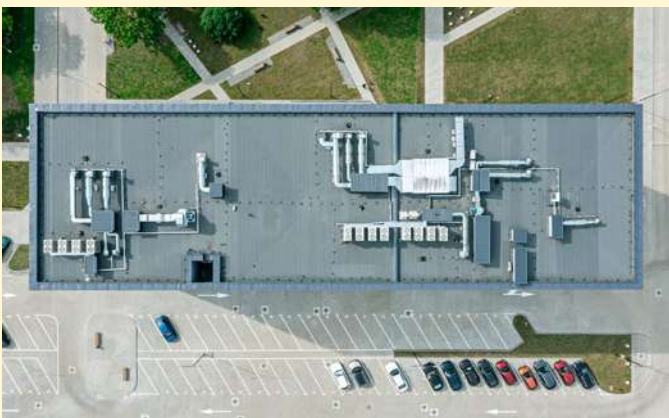
Insbesondere auf Dächern gewerblicher Betriebe stehen oft technische Aufbauten in Konkurrenz zur großflächigen Solarnutzung.
