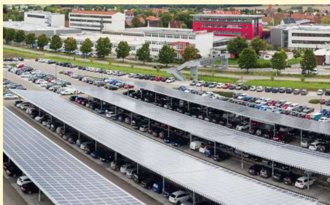
Photovoltaik-Parkplatz des Maschinenbauunternehmens Bausch+Ströbel in Ilshofen
