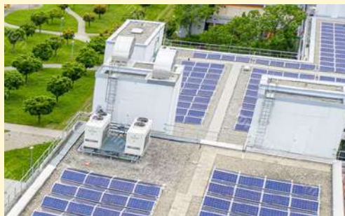
Gebäude benötigen für Lüftung, Kühlung, Aufzugschächte oder Tageslichtnutzung oft Aufbauten auf den Dachflächen die eine solare Nutzung räumlich einschränken aber in aller Regel nicht verhindern: Hochschule Reutlingen
