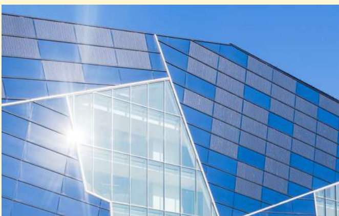
Solarfassade der Volksbank Karlsruhe
